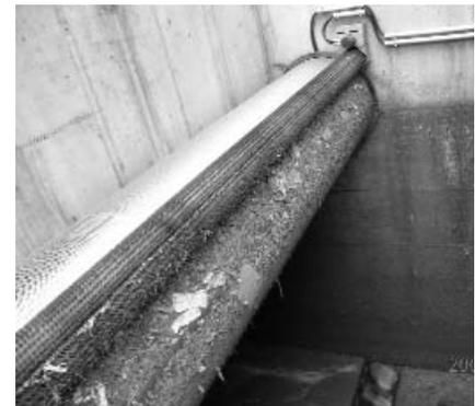
**Bild 1:** Trommeldrehfilter mit Filterkuchen nach Einstau ohne Abreinigung
