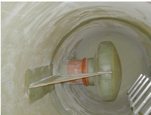
Figur 4 FluidVertic med PVC muffe - måner i GRP kum (her vist med ekstra forsterkning)
