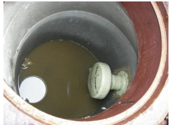
Figur 2 FluidVertic med buet monteringsplate installert i betongkum
