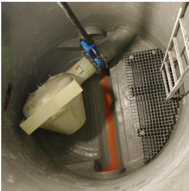
Figur 4 MFT virvelkammerkum med virvelkammer av typen FluidCon SUT-60
