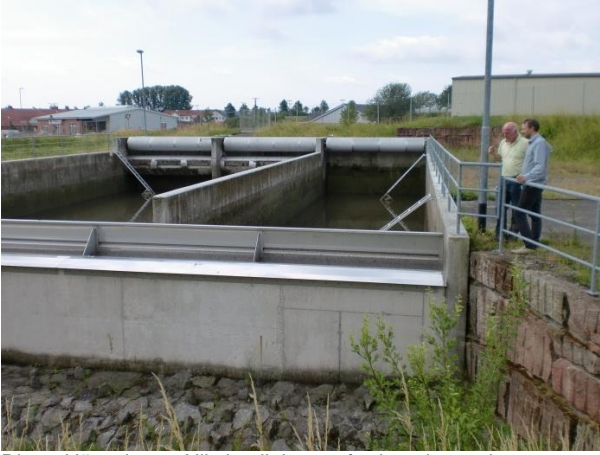
Dieter Häussler og Nils besiktiger et fordrøyningsanlegg nær Walldürn i Tyskland
