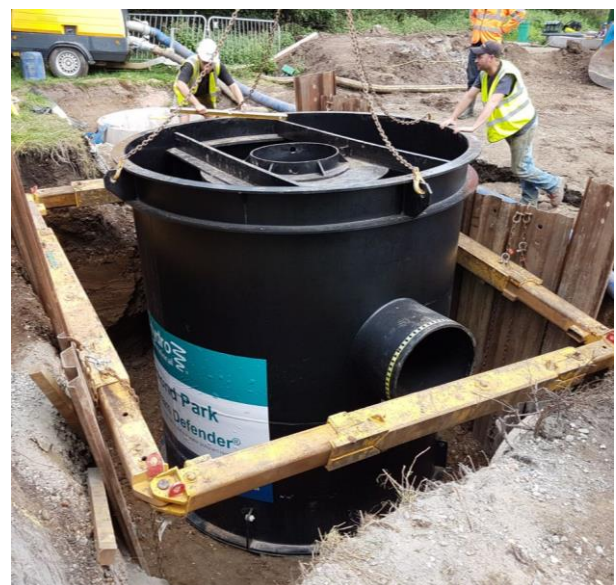
Montering av Downstream Defender® PE. Før støping.
