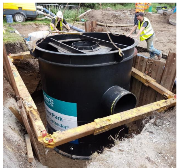
Montering av Downstream Defender® PE. Før støping.
