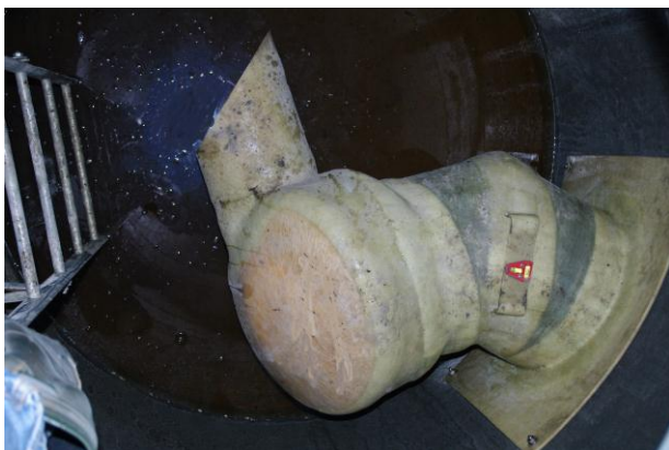
Figur 1 FluidCon med buet monteringsplate i kum
