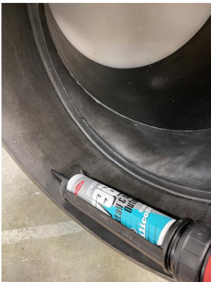
Påføring av silikon
