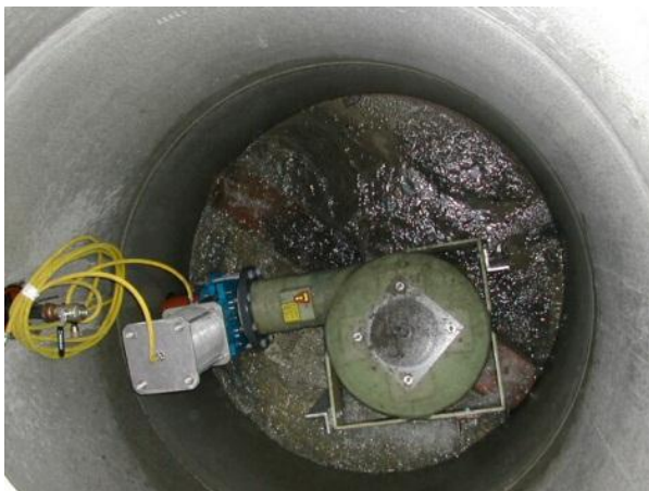
Figur 9 FluidCon SUt installert i betongkum. Montert med tilpassede festevinkler.
