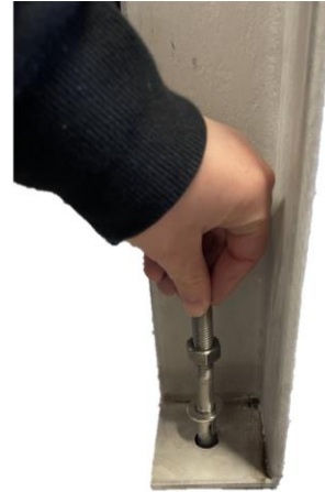
Forankring i kumgulv
