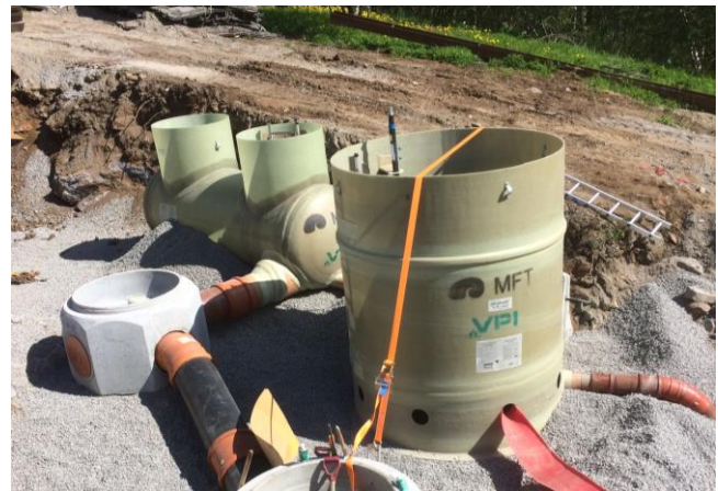
MFT GRP-kum med MFT tverroverløp under montering
