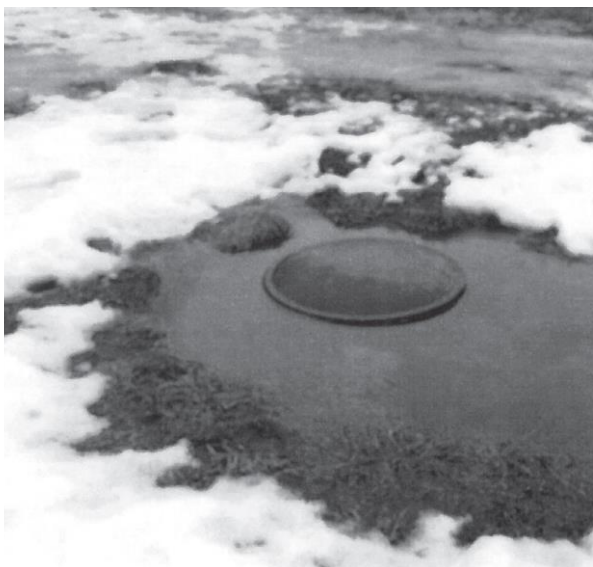
Figur 9 Resultatet av feil avrenning overflatevann
