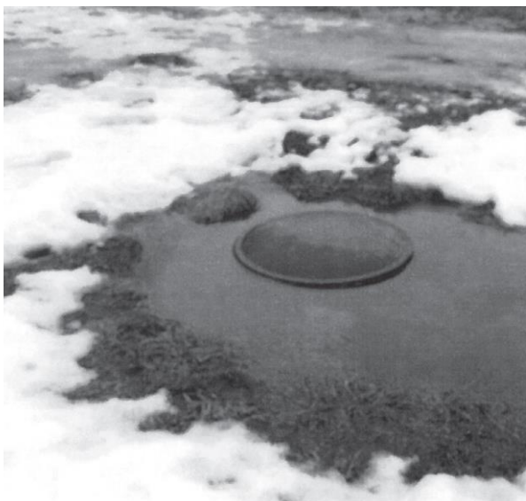
Figur 9 Resultatet av feil avrenning overflatevann
