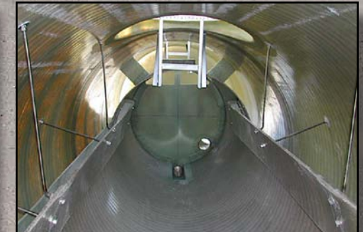
MFT høyt sideoverløp. Partikkelskillede regnvannsoverløp for store vannmengder
