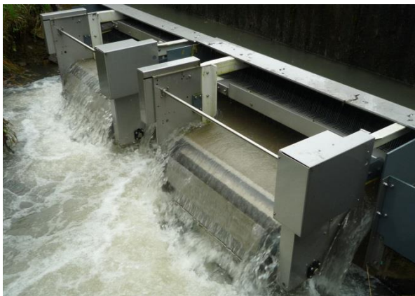
Figur 4 GiwaRechen - i overløpsdrift
