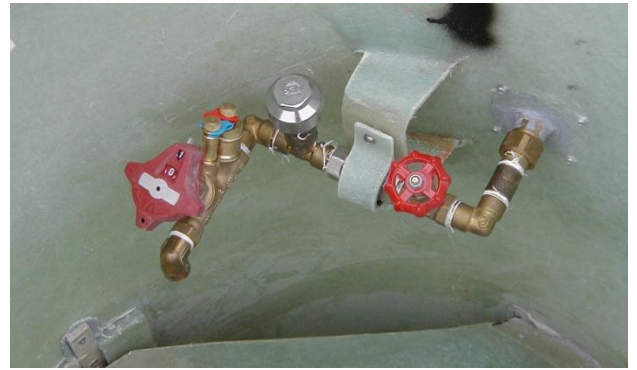
Figur 4 Reguleringsventil for spylemedie
